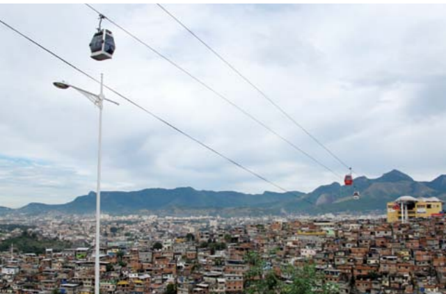
头顶忙碌运行的缆车
